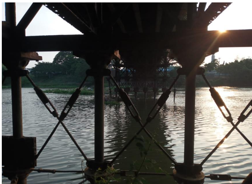
Foto 1.4 Besi penyangga Jembatan Lama
