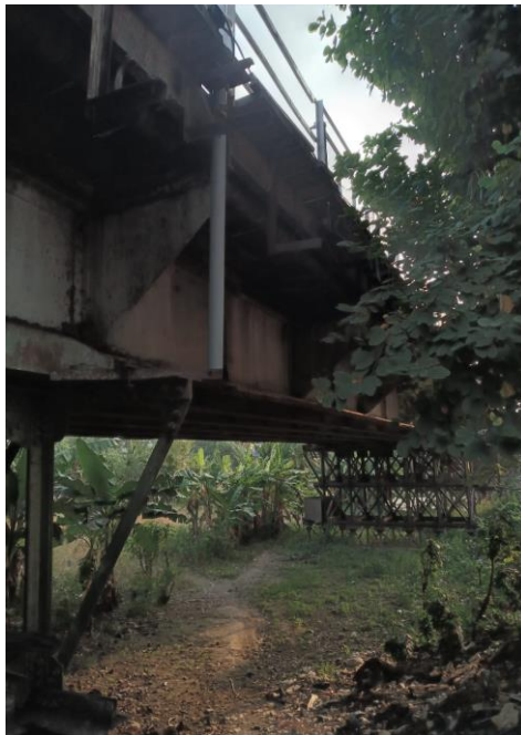
Foto 1.2 Jembatan Lama bagian bawah
