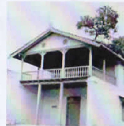
Panggung Hendro, bangunan pos penjaga bertingkat dua dekat Kori Talang Paten.
