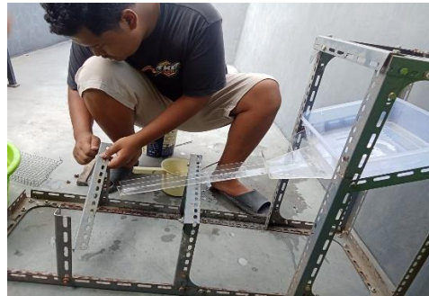
proses pemasangan penyangga
