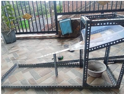
Proses pemasangan modul
