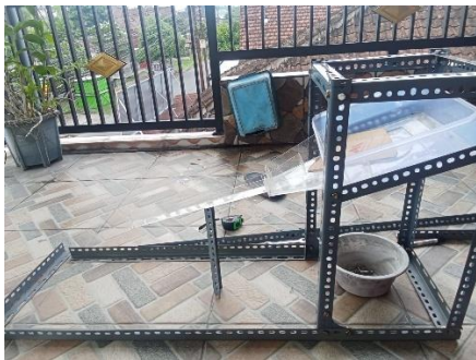
Proses pemasangan modul
