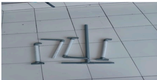
Gambar 3.3 Memotong untuk kaki penyeimbang (Sumber : Dokumen Pribadi 2024)
