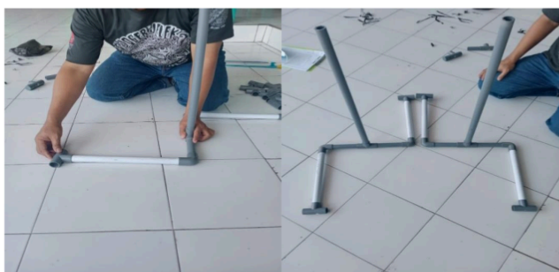
Gambar 3.10 Memasang kaki penyeimbang (Sumber : Dokumen pribadi 2024)
