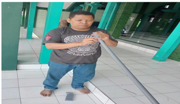
Gambar 3.1 Mengukur pipa paralon (Sumber: Dokumen Pribadi 2024)
