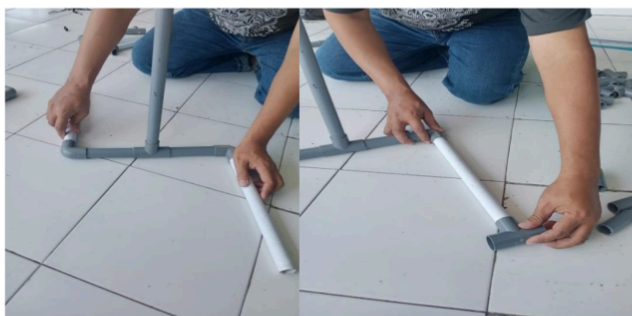
Gambar 3.9 Memasang kaki penyeimbang (Sumber : Dokumen pribadi 2024)
