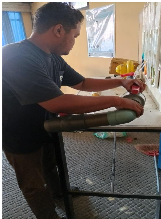
Gambar 2 Pemasangan Katub Kran
