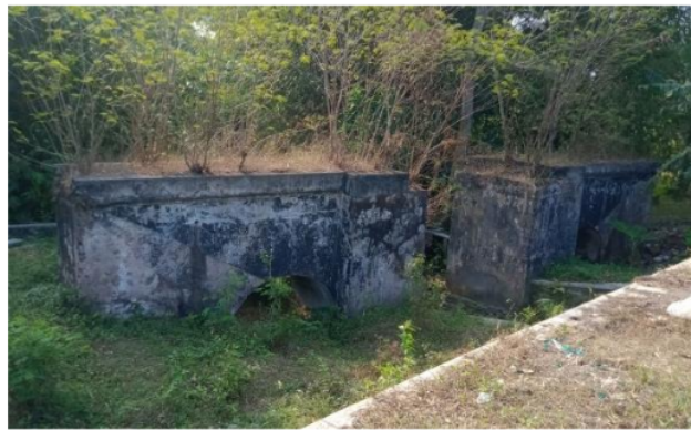
Gambar 4.13 bekas abutment jembatan tram peninggalan KSM (sumber : dokumentasi pribadi, 2022)
